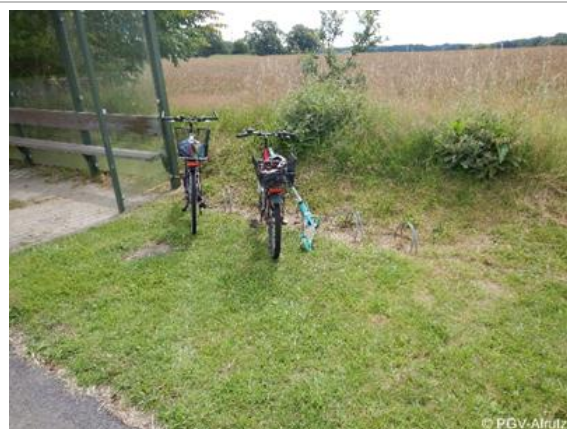
Nicht anforderungsgerechte Vorderradklemmen auf unbefestigtem Untergrund (stark zugewachsen) – Bushaltestelle L 134 (Vaale)
