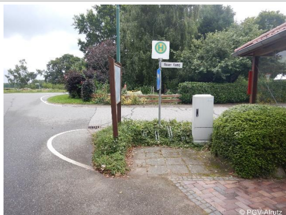
Nicht anforderungsgerechte Vorderradklemmen auf befestigtem Untergrund (stark zugewachsen) – Bushaltestelle Wiesengrund (Eversdorf)
