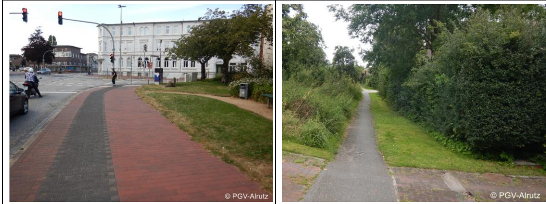
Abb. 4-6: Beispiele für zu schmale Radverkehrsanlagen. Links: nicht Benutzungspflichtiger Einrichtungsradweg innerorts in Itzehoe, Rechts: gemeinsamer Geh- und Radweg außerorts bei Herzhorn,
