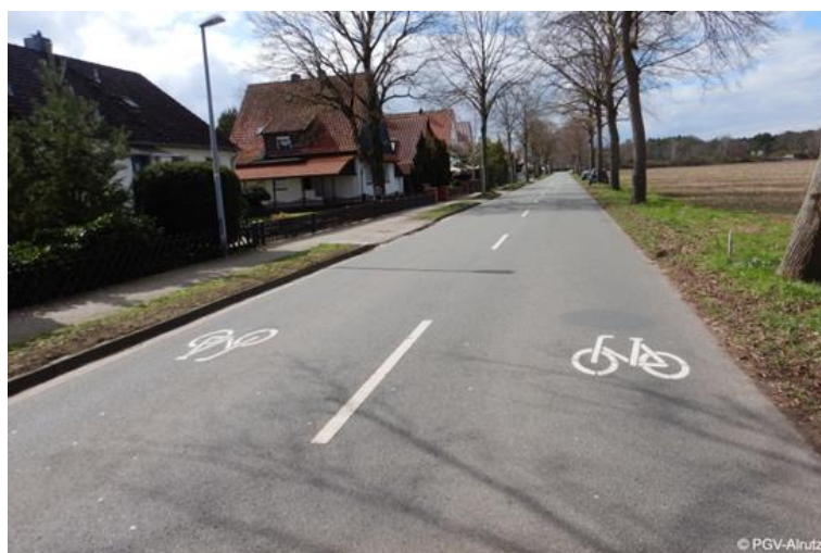
Abb. 4-8: Beispiel für beidseitige Piktogrammketten (Poggenhagen)
