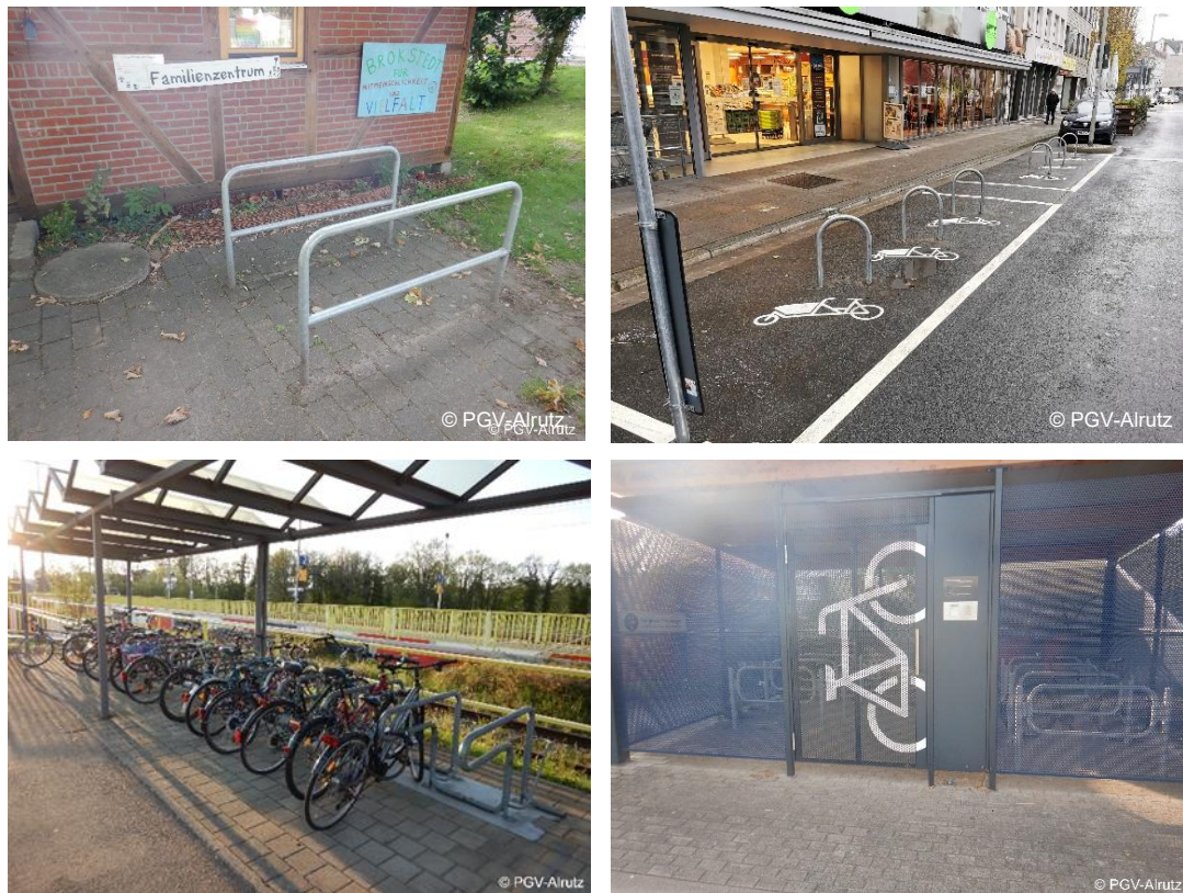
Abb. 5-1 Rahmenhalter mit Doppelholm (Familienzentrum Brokstedt, oben links), verkürzte Rahmenhalter (oben rechts), überdachte Vorderradrahmenhalter (unten links) und Sammelschließanlage (Bahnhof Brokstedt, unten rechts)
