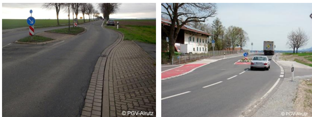
Abb. 4-10 Beispiele zur Gestaltung von Ortseingängen mit Überführung des Radverkehrs von richtungstreuer Führung innerorts in die einseitige Zweirichtungsführung im Seitenraum außerorts im Landkreis Wolfenbüttel (links) und im Raum Rosenheim (rechts).
