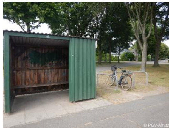
Anforderungsgerechte Anlehnbügel auf unbefestigtem Untergrund – Bushaltestelle L 121 Kieler Straße (Hohenlockstedt)
